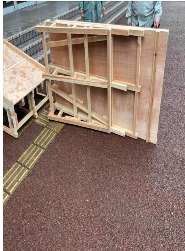
春や夏暖かい期間は使用できるが冬の時期は積雪もあり危険な為このような手作りの簡易スロープを使用する。用務員さんの手作りで工夫した所は倒れない、崩れないことを重視して作られています。加えてタイヤの幅に合わせて止めを付けるという点も工夫されている。
